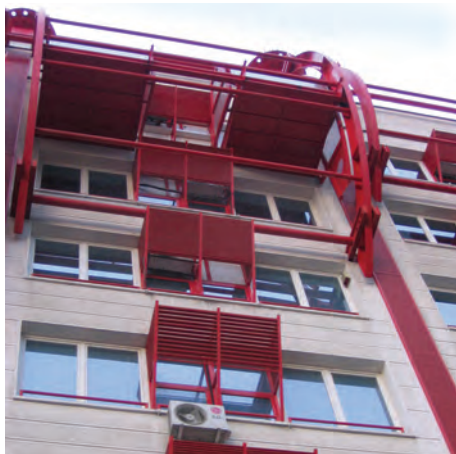
Сл. 34. YUBC – примери негативног коришћења испуста на фасади - детаљи (арх. Марио Јобст) Fig. 34. YUBC –examples of negative usage of façade drains – details (arch. Mario Jobst)
