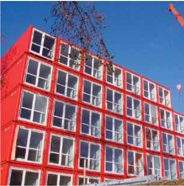
Сл. 3. Највећи комплекс састављен од контејнера - студентски дом у Амстердаму са 1000 јединица, 2006. (аутори: Темпохаусинг ( Tempohousing )) Fig. 3. The largest complex composed of containers- student housing in Amsterdam with 1000 units, 2006. (authors: Tempo-housing)
