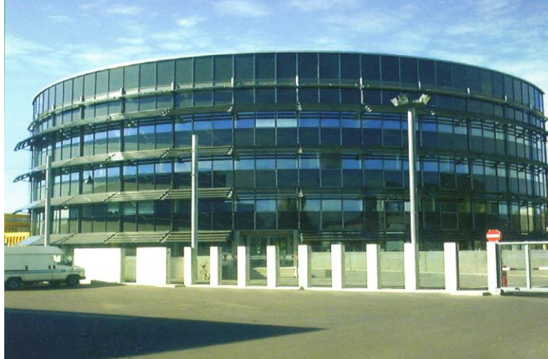
Slika 04. Solarna elektrana snage 20kWp u gradu Linz-u
