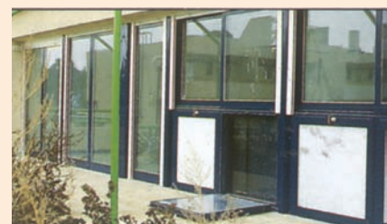
Сл. 10. Тромбеов (а) и водени зид (б) на објекту у насељу Ликовриси Fig. 10. Tromb's (a) and water wall (b) on the Lykovrissi settlement building
