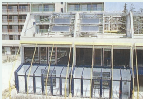
Сл. 2. Изградња стамбеног насеља Ликовриси Fig. 2. Lykovrissi settlement realization
