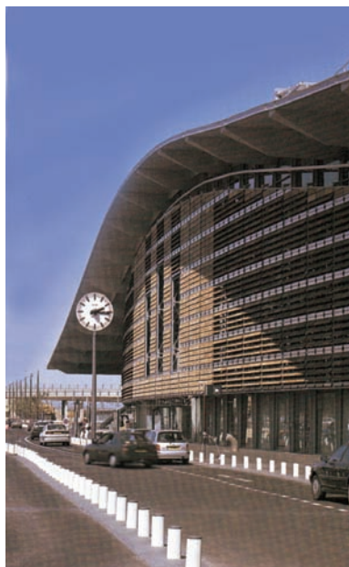
Сл. 19. Главни приступ згради западне оријентације Fig. 19. Main west entrance
