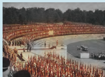
Сл. 5. Фирер одлази са градилишта Музеја немачке уметности, Минхен Збор С.А. одреда, Нирнберг 1938 Fig. 5. The Führer leaves building site for the House of German Art The S.A. rally, Nuremberg 1938.
