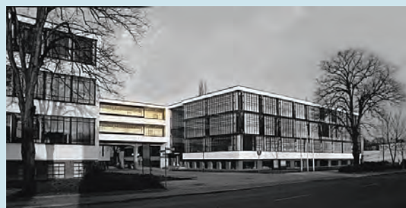
Сл. 3. Зграда Баухауса- крило са радионицама Fig. 3. The Bauhaus building-workshop wing
